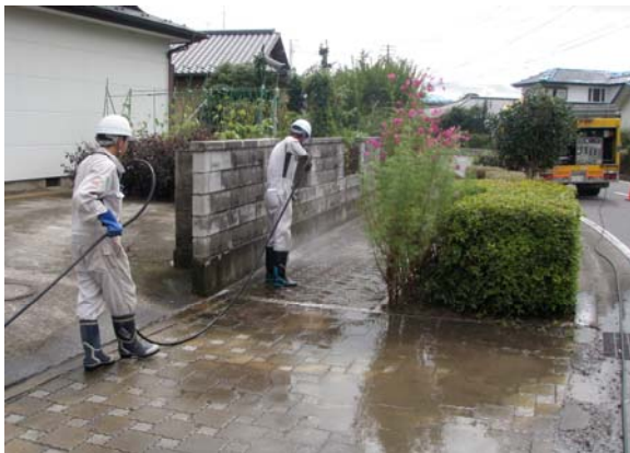
【放射性物質高圧除染作業】
