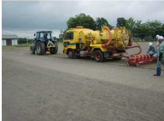
【表土除去除染作業】
